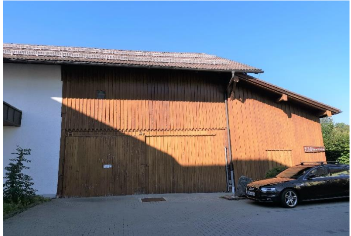
Nordansicht der Lagerhalle.
