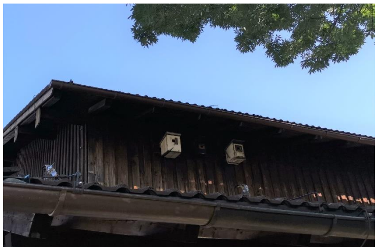
Angebrachte Nistkästen an der Südseite der Lagerhalle.
