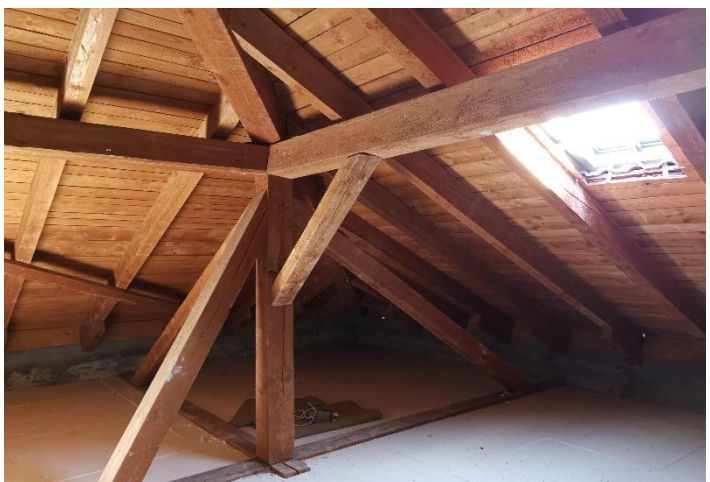
Innenansicht des Dachbodens in der Theaterstraße.
