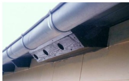
Passgenaue Holzkasten zwischen Balkenköpfen
