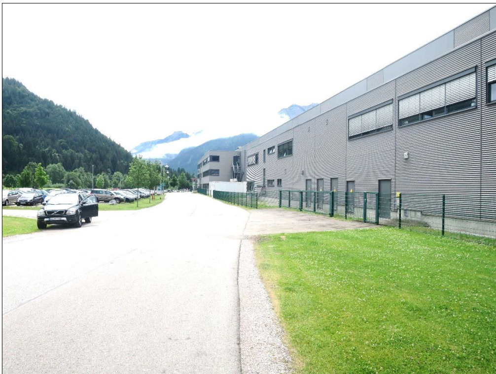
Abb. 13: Ansicht Nordwestfassade Werk 3 (Halle M) gemäß [i]
