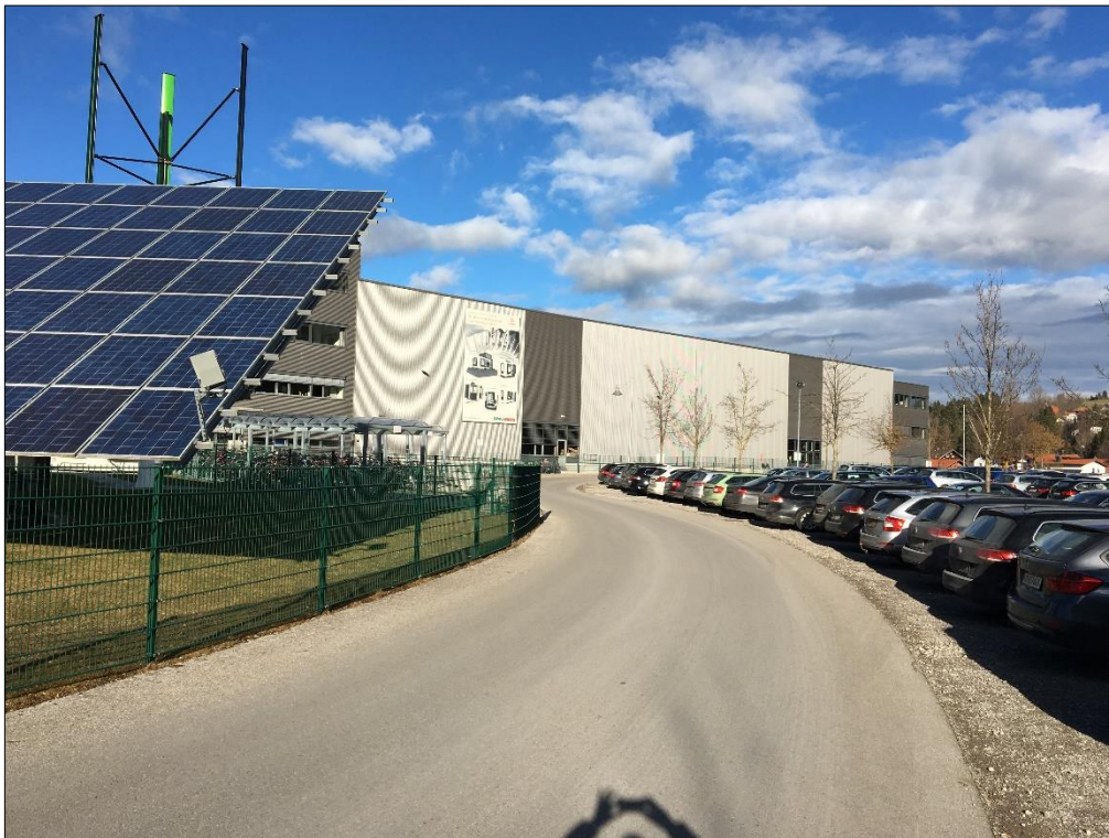
Abb. 3: Ansicht Südostfassade Hallen L und M sowie Verwaltung V3 gemäß [i]
