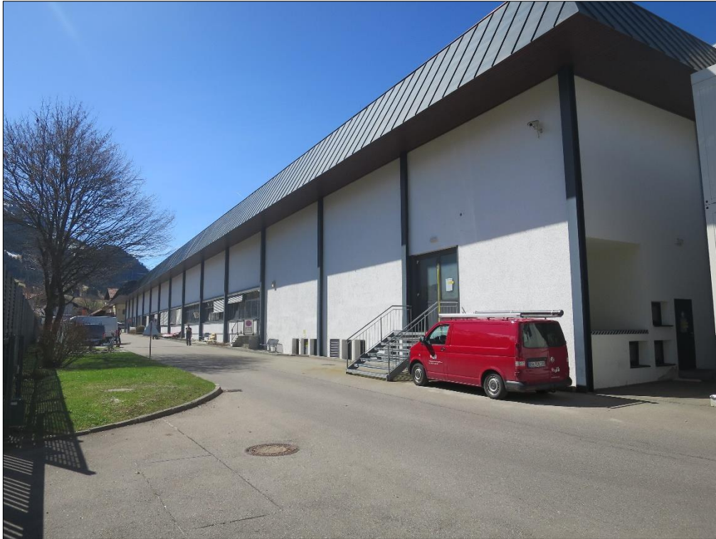
Abb. 6: Ansicht Südostfassade Halle B gemäß [i]
