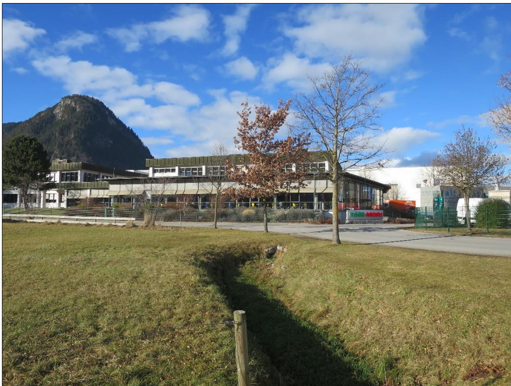
Abb. 5: Ansicht Südostfassade Verwaltung V4/Kantine gemäß [i]
