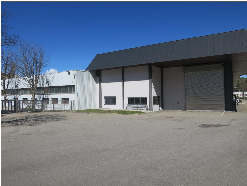
Abb. 7: Ansicht Südwestseite Halle B sowie Elektrowerkstatt gemäß [i]
