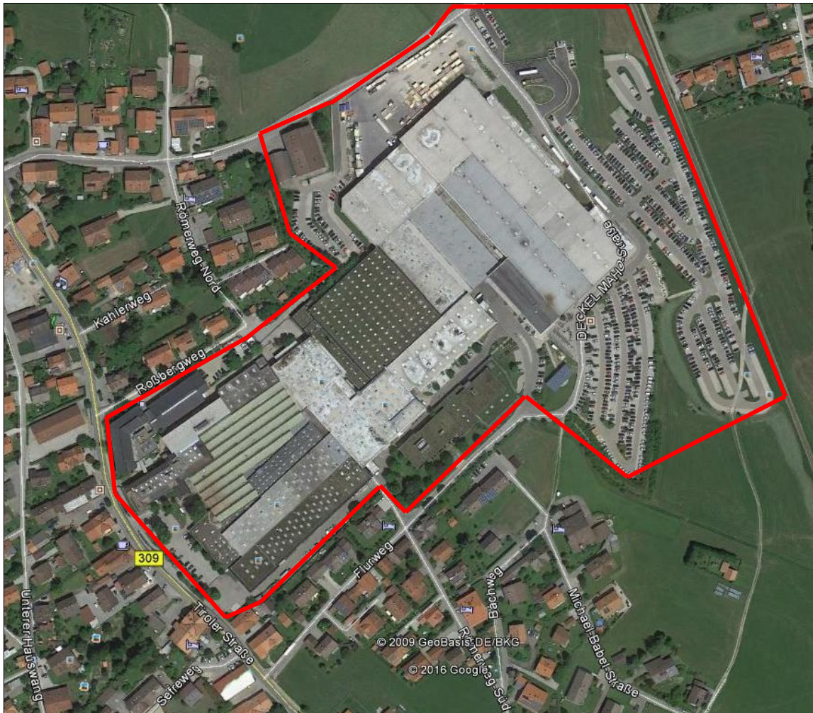
Abb. 1: Luftbildaufnahme mit Darstellung des Werksgeländes der "DECKEL MAHO Pfronten GmbH" (Stand: 04/2018) sowie der unmittelbaren Umgebung [Quelle: google earth]
