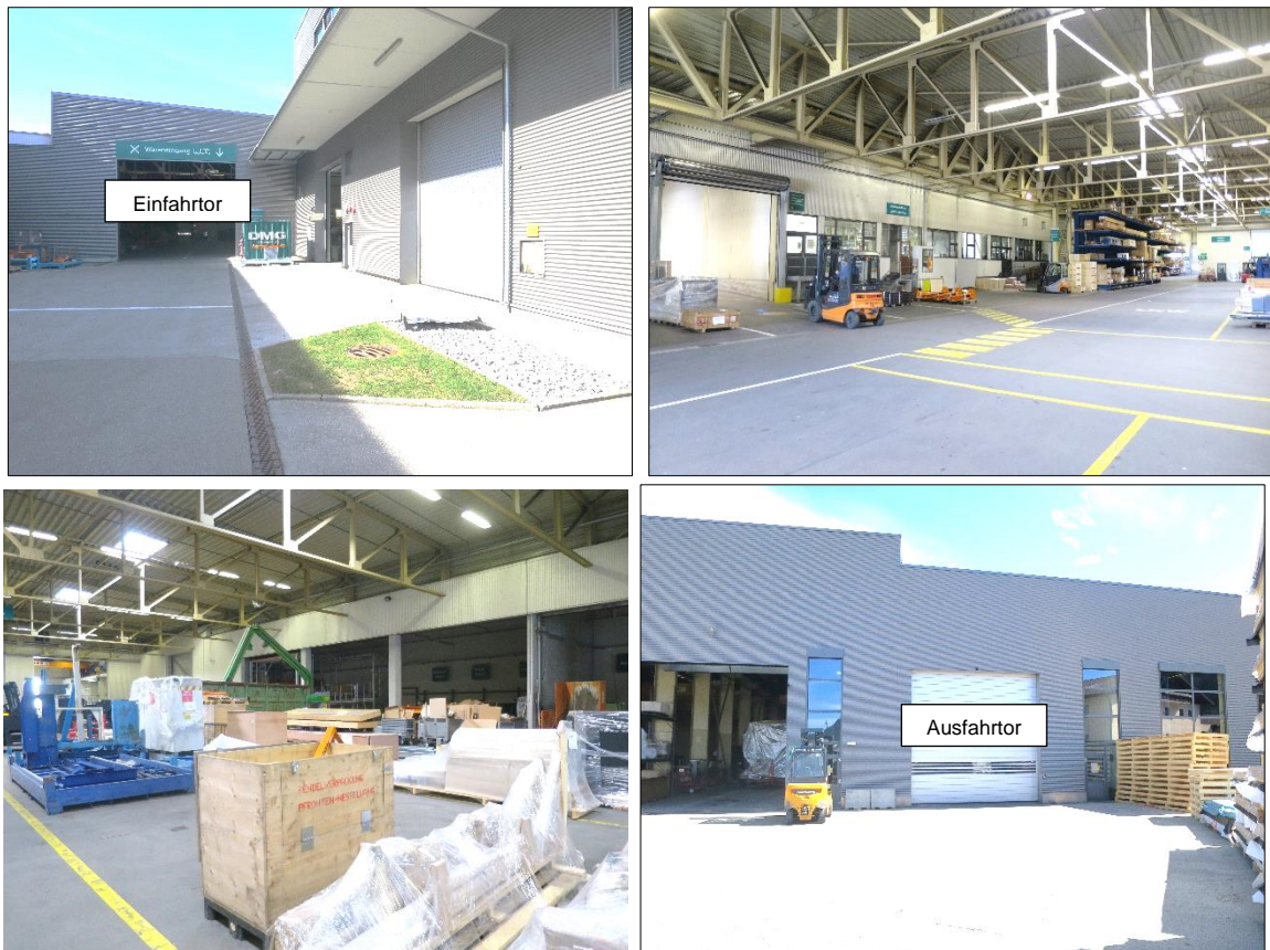
Abb. 15: Halle I bzw. Ladehof gemäß [i]
