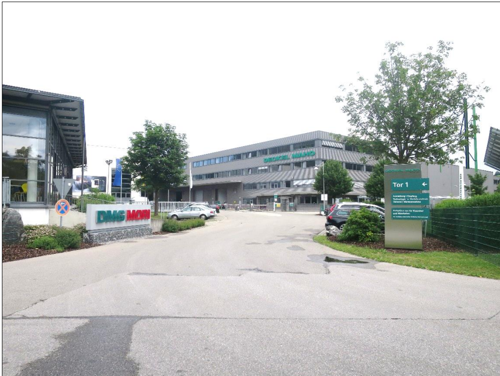
Abb. 4: Ansicht Hauptforte und Südwestseite Verwaltung V3 gemäß [i]
