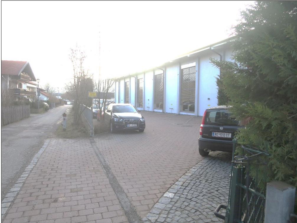
Abb. 10: Ansicht Nordwestseite Werk 6 gemäß [i]
