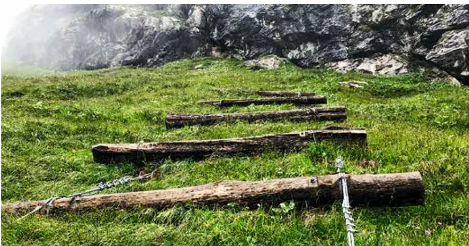
**In Oberstdorf wird so der Lawinengefahr begegnet – dieses System wird nun auch am Breitenberg installiert.**
