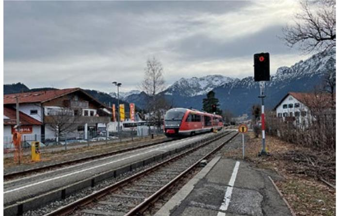
Die DB baut in diesem Jahr zwei neue Außenbahnsteige an die bestehenden Gleise 3 (links) und 2 (mitte). Das ehemalige Gleis 1 (rechts) wird zurückgebaut. Der Zugang zu Gleis 3 erfolgt künftig über den Bahnübergang der Meilinger Straße.
