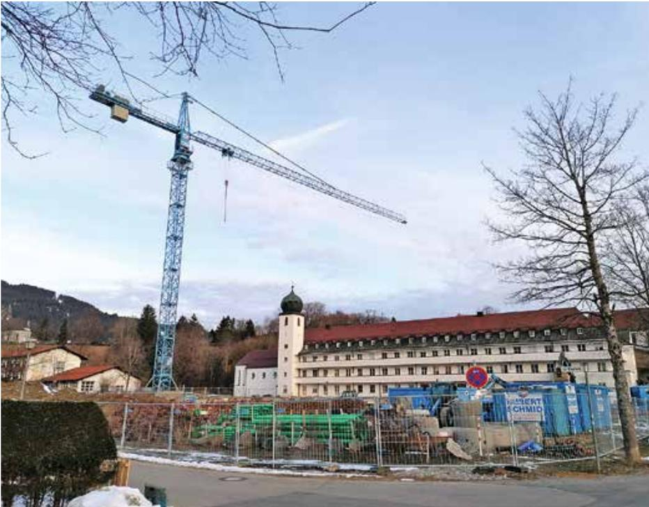
Die im Oktober 2021 begonnenen Arbeiten für den Erweiterungsbau der St. Vinzenz Klinik konnten bereits Ende Februar nach einer kurzen Winterpause wieder aufgenommen werden. Die Kräne wurden aufgebaut und aktuell werden die Fundamente erstellt. Die Planung sieht vor, dass der Rohbau bis Ende des Jahres steht, um anschließend mit den Innenarbeiten beginnen zu können.
