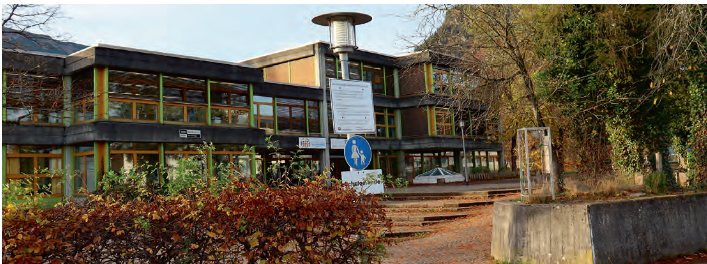
Die Mittelschule vor der Sanierung (linkes Foto). Nun sind die Bauarbeiten in vollem Gange.
