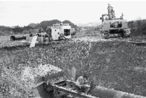
*Durchpressung der Bahnlinie für den Kanalbau*
