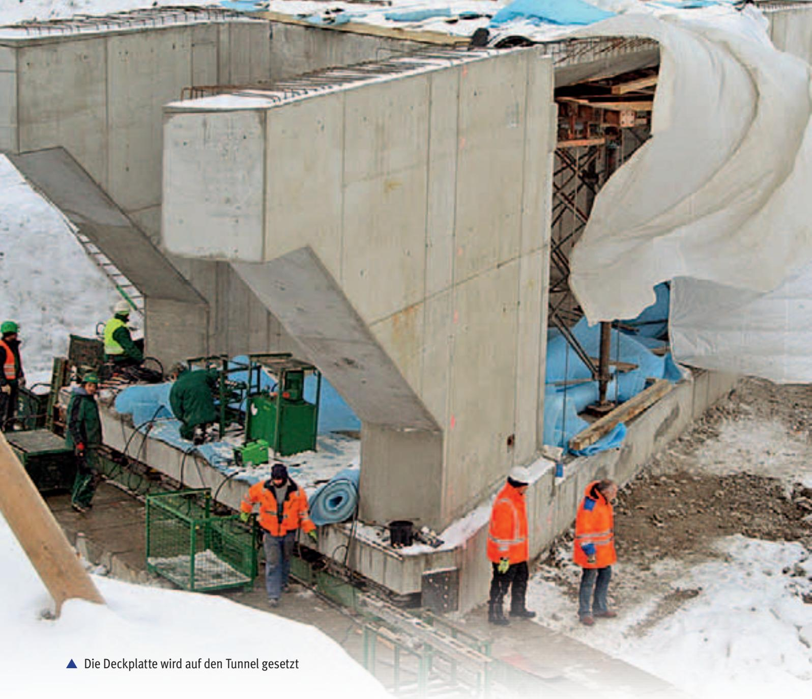
▲ Die Deckplatte wird auf den Tunnel gesetzt
