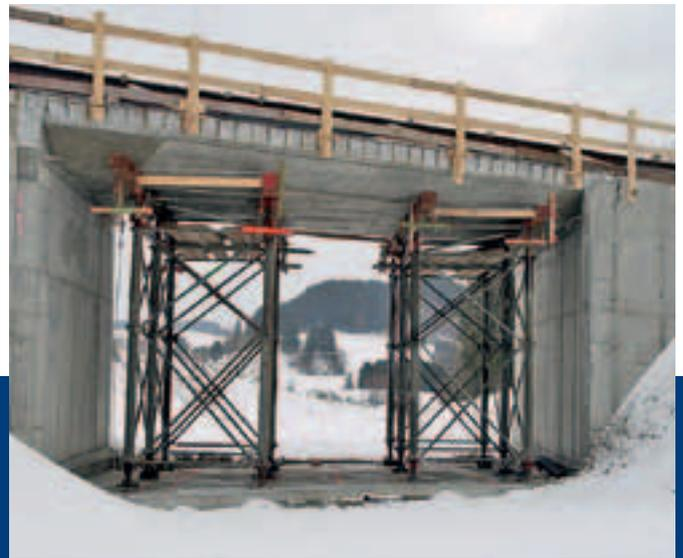
▲ Die Deckplatte wird auf den Tunnel gesetzt
