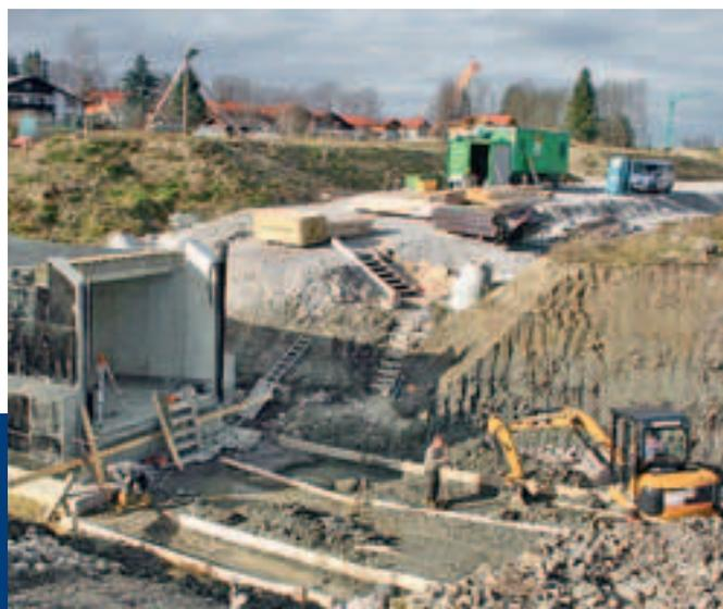
▲ Fertig betonierte Tunnel werden verschoben
