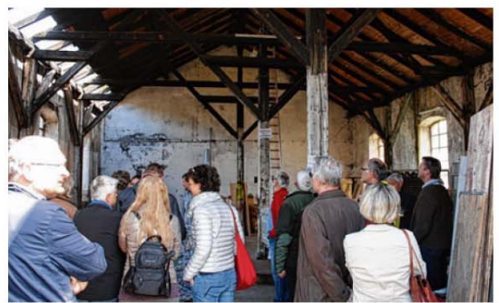
Von der Ruine zum attraktiven Veranstaltungsort oder auch einer Markthalle? Der ehemalige Lokschippen bietet viel Raum für Ideen.
